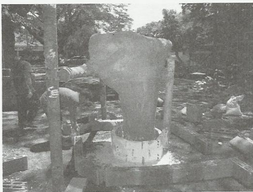
ภาพที่ 10 การขึ้นโทนและการก่ออิฐบล็อกจากชั้นรอบหุ่นพระ
